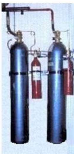
Figura 8. Sistema de extinción fijo con halón 1301. Fuente: CBCM.
